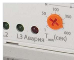
При выходе всех трех фаз за установленные пороги нагрузка отключается и начинает моргать индикатор «Авария».
